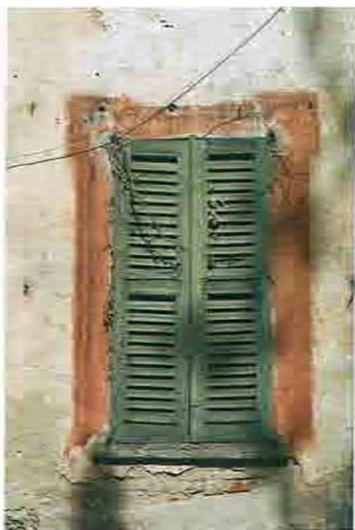
fot. 31 - 32 veduta esterna "tipo" della gelosia delle finestre con relativa cornice a decoro e portoncini esterno "tipo".
