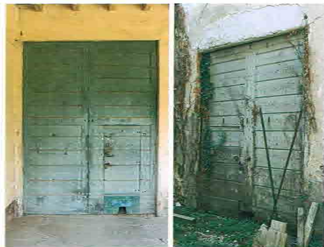
fot. 22 - 23 veduta dei due portoni in legno della galleria: il progetto prevede la loro rifunzionalizzazione, restauro con integrazione delle sole porzioni di legname marciscente e ripresa dei meccanismi di chiusura.
