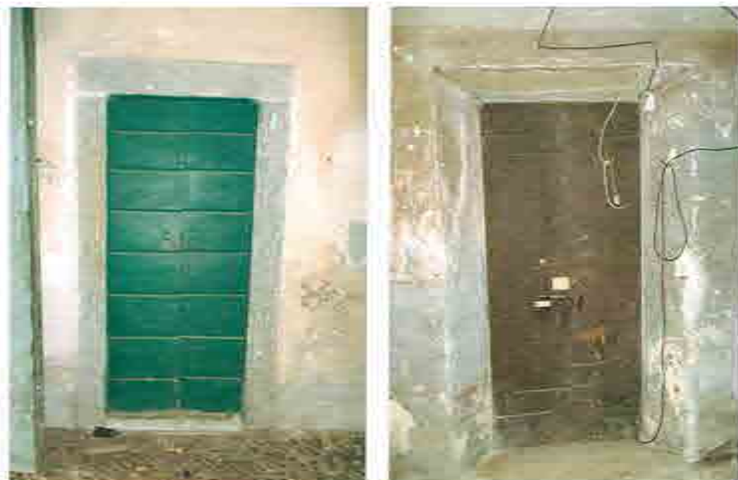
fot. 67 - 68 - 69 veduta delle porte interne che si intendono recuperare
