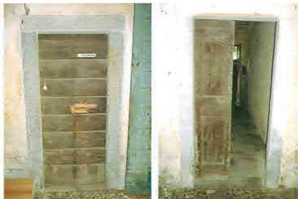
fot. 70 - 71 - 72 veduta delle porte interne che si intendono recuperare
