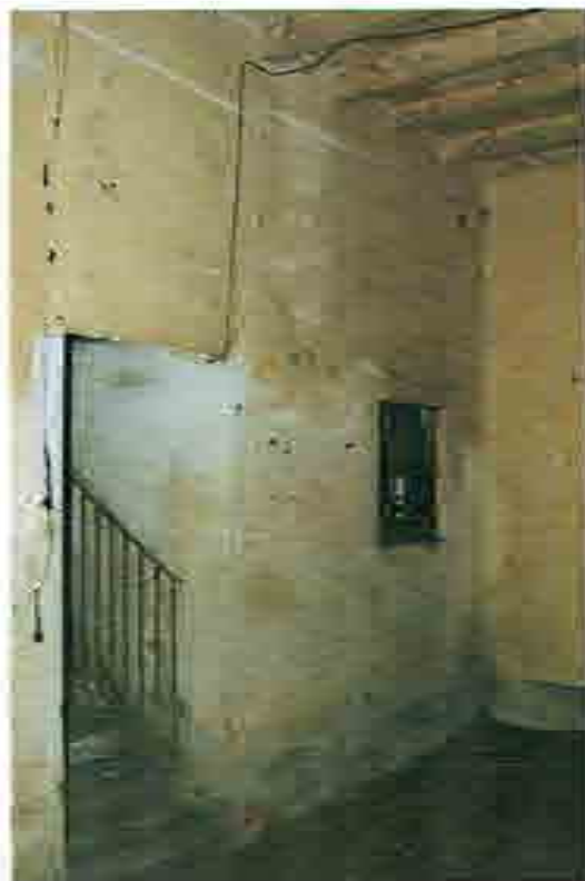
fot. 5 - 6 veduta del vano scala centrale alla galleria di piano terra di cui il progetto prevede la demolizione e la ricostruzione mediante nuova geometria a doppia rampa e il recupero delle pedate esistenti in beola bianca.
