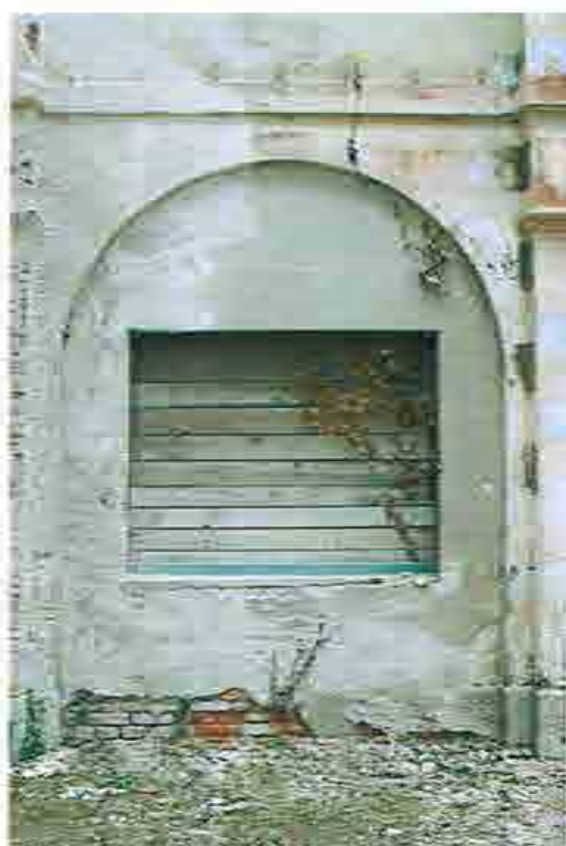
fol. 26 - 27 veduta dei tre archi tamponati con una muratura di recente costruzione che il progetto prevede di demolire e di sostituire con un nuovo serramento in ferro e vetro.
