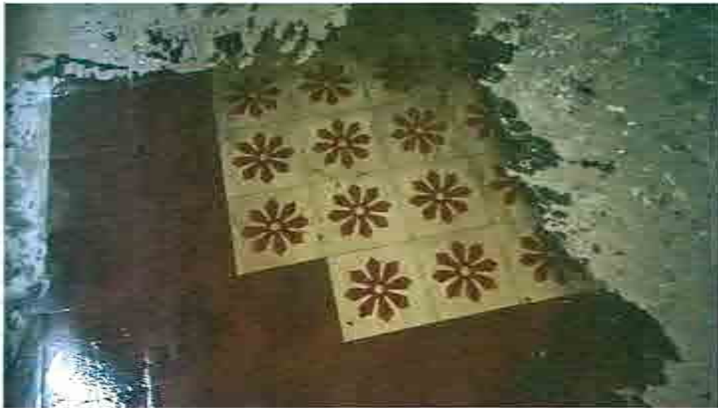
fot. 48 veduta interna "tipo" della pavimentazione in piastrelle di cemento e graniglia colorata a disegni floreali (previsione di recupero per la nuova caffetteria).
