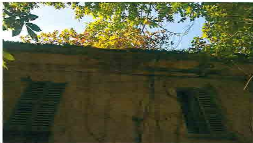
fol. 12 veduta del cornicione di gronda che sarà oggetto di un intervento di consolidamento strutturale
