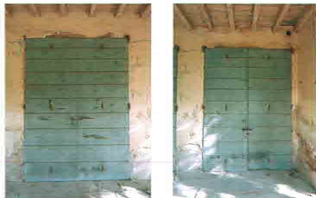
fot. 22 - 23 veduta dei due portoni in legno della galleria: il progetto prevede la loro rifunzionalizzazione, restauro con integrazione delle sole porzioni di legname marciscente e ripresa dei meccanismi di chiusura.
