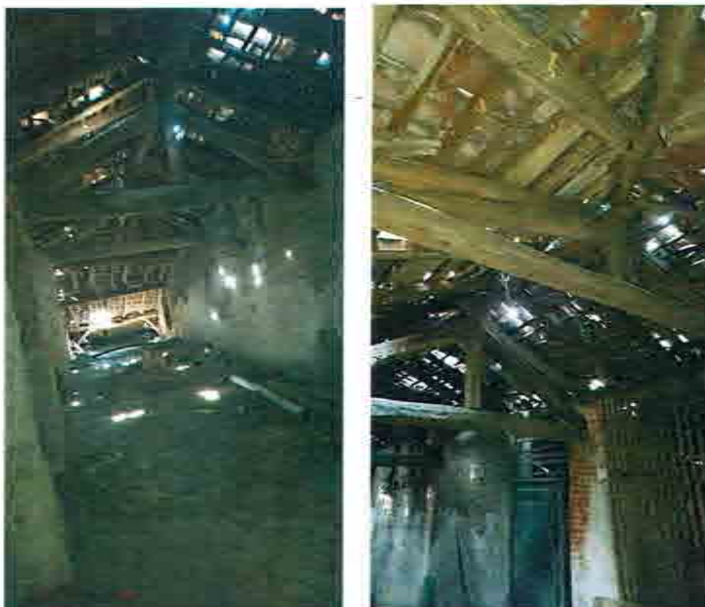
fot. 7 - 7 bis veduta generali della struttura del tetto e del manto di copertura prevalentemente composta di coppi a canale.
