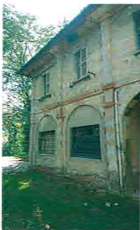
fol. 26 - 27 veduta dei tre archi tamponati con una muratura di recente costruzione che il progetto prevede di demolire e di sostituire con un nuovo serramento in ferro e vetro.
