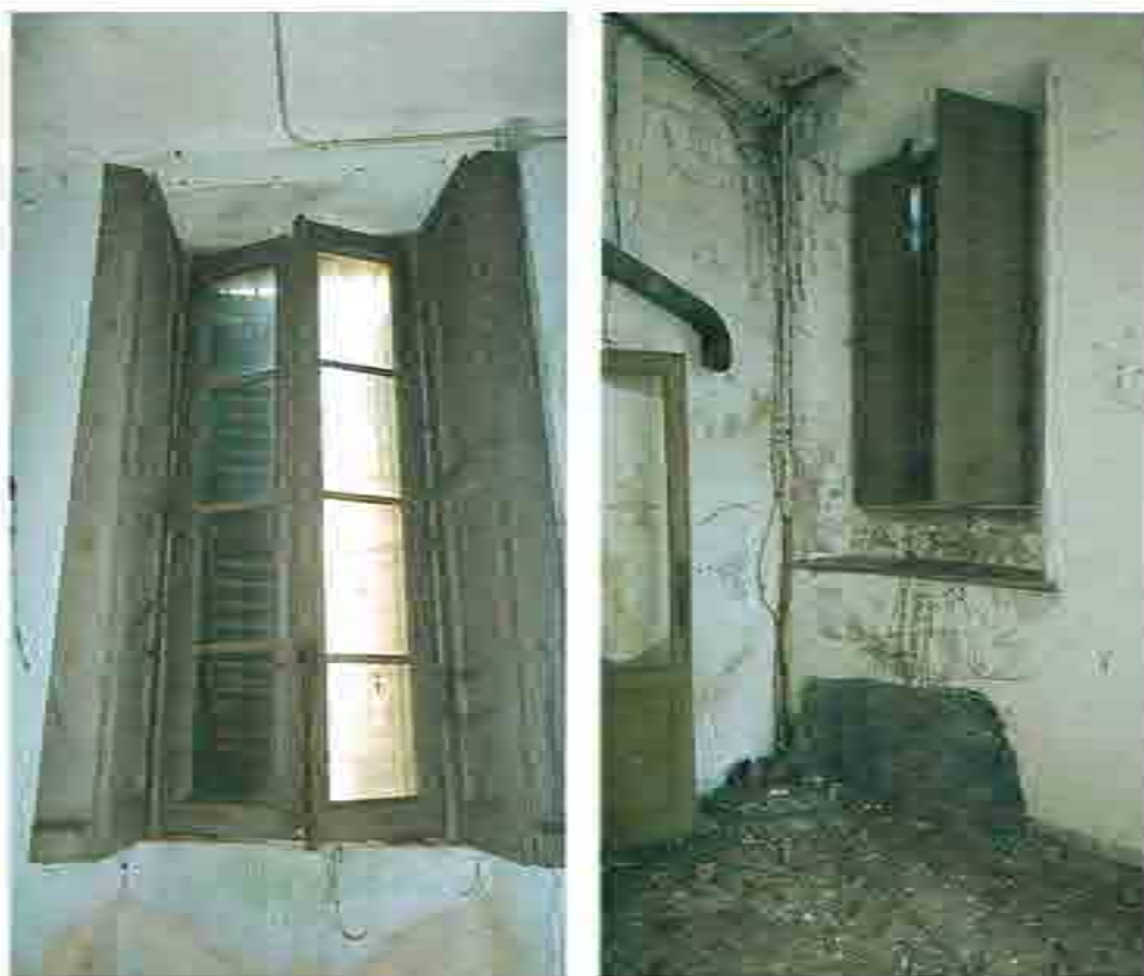
fol. 29 - 30 veduta interna "tipo" del serramento interno delle finestre in legno con vetro e relative ante scure.
