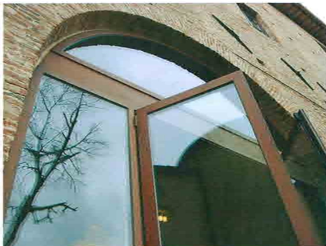
figura 4: modello dei nuovi serramenti in ferro e vetro.
