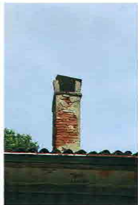
fot. 8 - 9 veduta di uno degli otto comignoli e dell'elemento porta parafulmine che il progetto prevede di conservare tramite interventi di consolidamento / ricostruzione fedele delle piccole porzioni crollate
