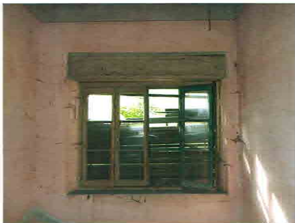
fol. 26 - 27 veduta dei tre archi tamponati con una muratura di recente costruzione che il progetto prevede di demolire e di sostituire con un nuovo serramento in ferro e vetro.
