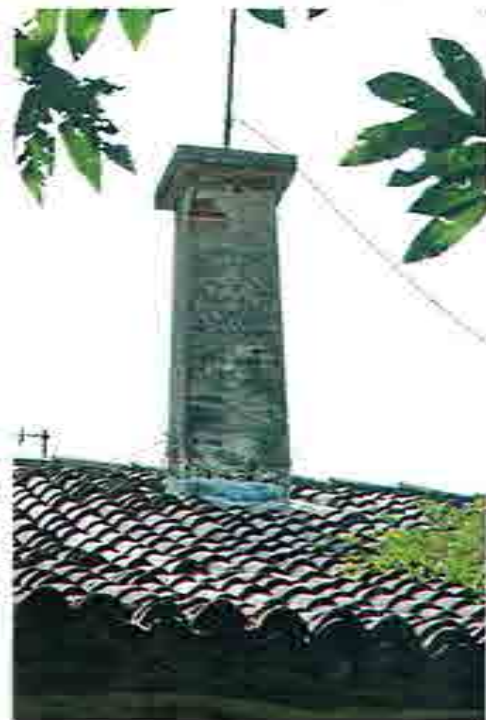
fot. 8 - 9 veduta di uno degli otto comignoli e dell'elemento porta parafulmine che il progetto prevede di conservare tramite interventi di consolidamento / ricostruzione fedele delle piccole porzioni crollate
