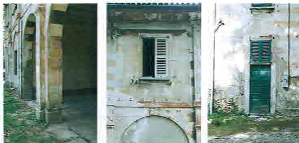
fat. 18 - 19 - 20 veduta di alcuni degli apparati lapidei oggetto di intervento di pulitura: basamenti pilastri del portico, davanzali, spalle e architravi delle porte.
