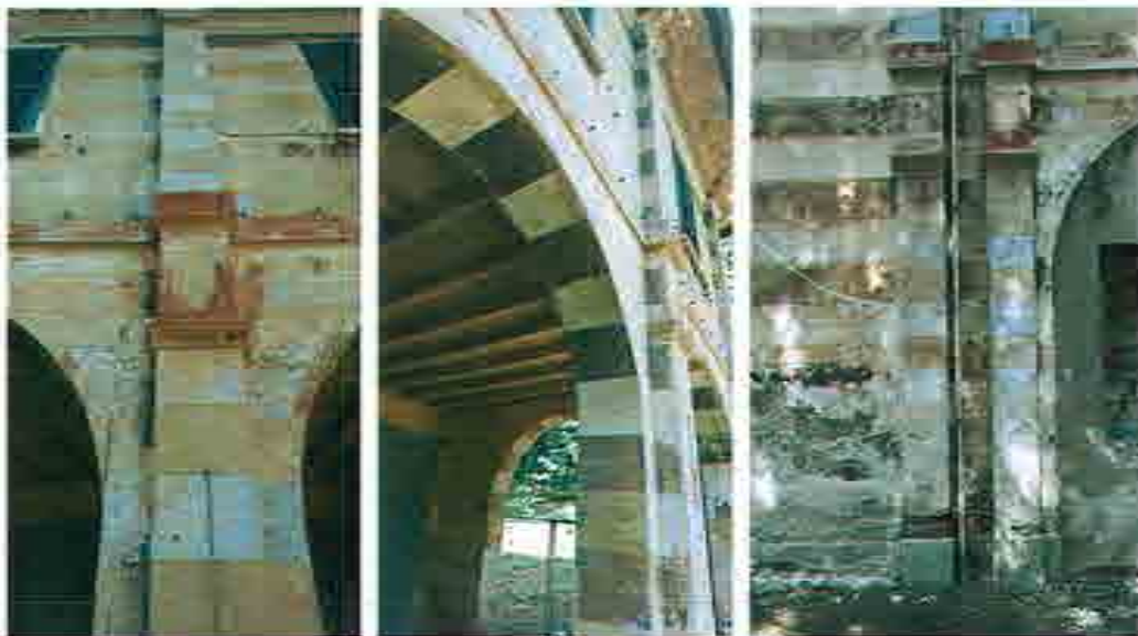
fol. 13 - 14 - 15 veduta delle decorazioni pittoriche di facciata che saranno oggetto di sole lavorazioni di carattere conservativo senza alcuna concessione al rinnovo o al ripristino di elementi - anche se geometricamente riproponibili.
