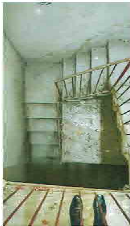
fot. 5 - 6 veduta del vano scala centrale alla galleria di piano terra di cui il progetto prevede la demolizione e la ricostruzione mediante nuova geometria a doppia rampa e il recupero delle pedate esistenti in beola bianca.
