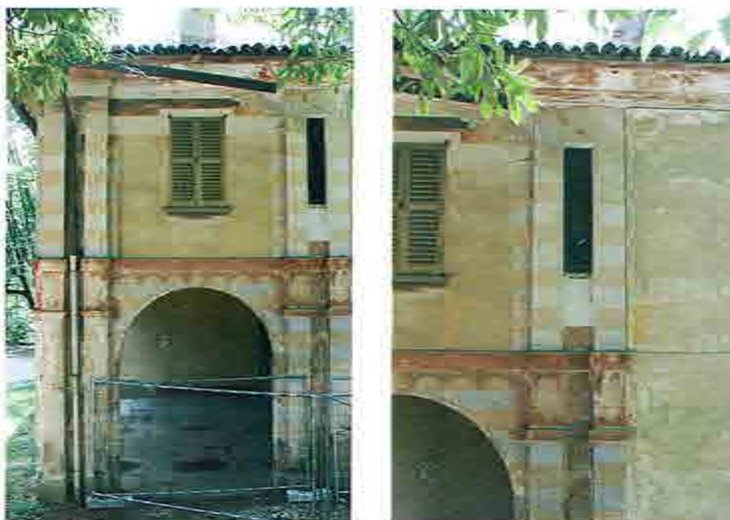
fig. 16 - 17 veduta delle decorazioni pittoriche di facciata che saranno oggetto di sole lavorazioni di carattere conservativo senza alcuna concessione al rinnovo o al ripristino di elementi - anche se geometricamente riproponibili.
