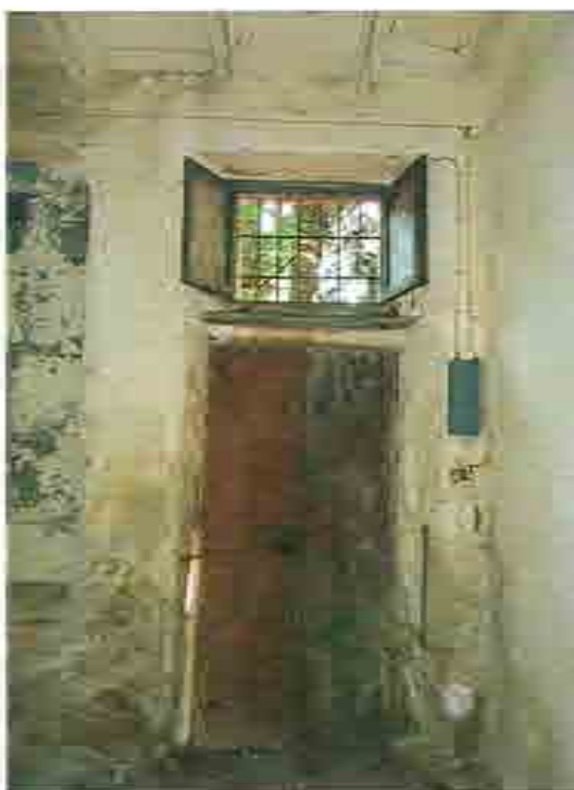
fot. 33 - 34 veduta interna "tipo" del portoncino delle porte di ingresso e del serramento della finestra con vetri e grata in ferro.
